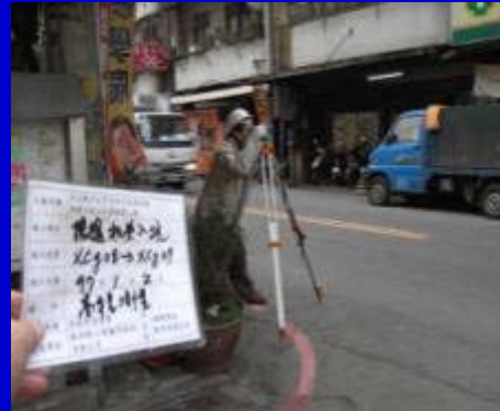
(XCg09) 高程測量作業
