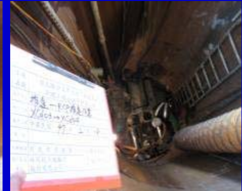
(XCd04) 機頭推進作業
