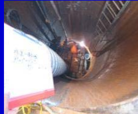
(XCa08a) 鏡面安裝作業
