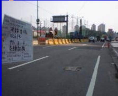
(XCh13) 交維佈設作業
